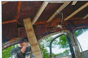
Au centre du pavillon, il y avait un gros effondrement. Comme si une masse importante était tombée dessus. Nous avons imaginé pouvoir le redresser en utilisant un cric et des madriers. Mais le résultat n'étant pas à la hauteur de nos espérances, nous avons finalement pris la décision de patienter pour trouver une autre Traction en épave mais dont le toit serait en bon état.
